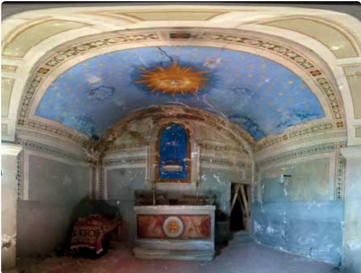
Abside - Analisi stato di conservazione
